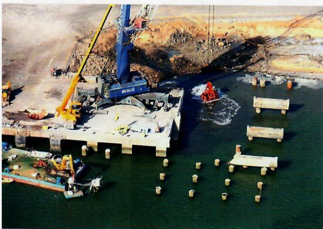
Kai mit vorgelegenen Stahlbetonpfeilern
