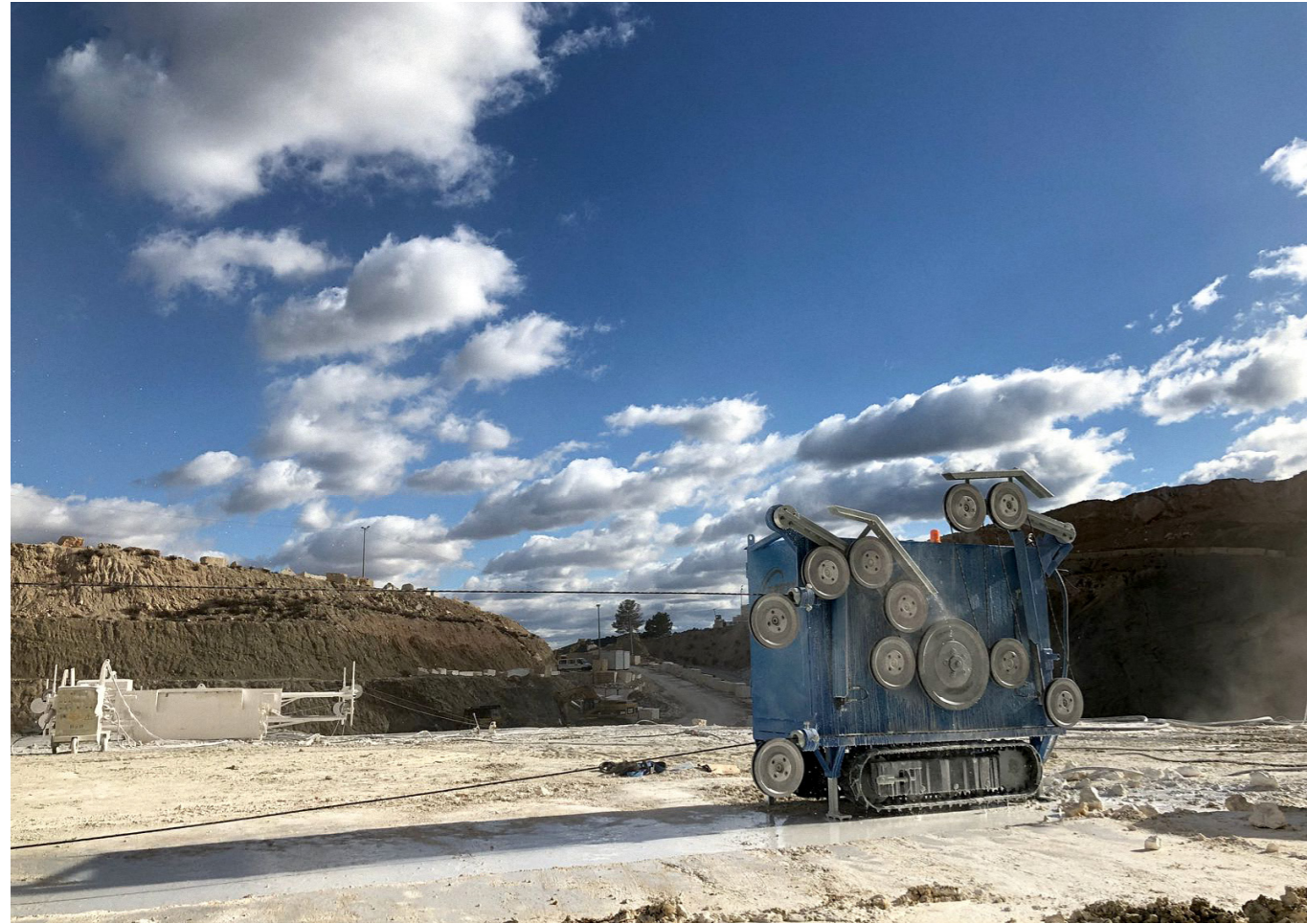
Die neue H 50 BTM im Baustelleneinsatz.
