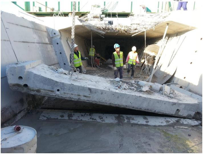
Cuarta Fase: Corte de estructura del viaducto en su unión con la pila, realizado con hilo de diamante.
